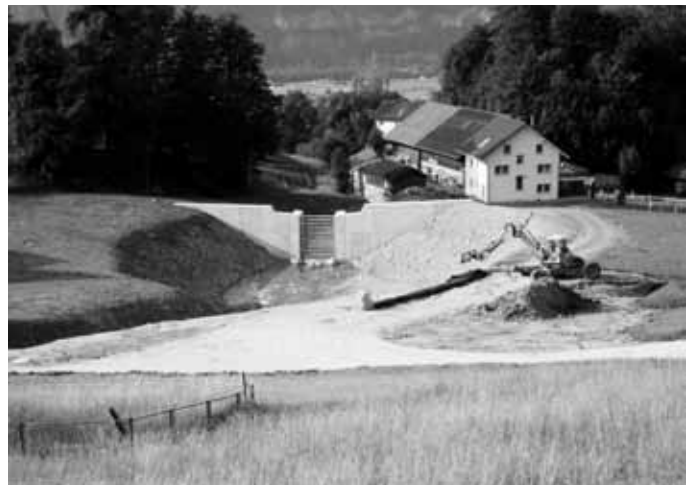
Rückhaltebecken «Hof», Ansicht von Norden
