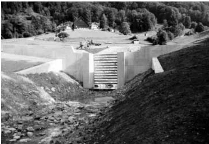
Rückhaltebecken «Hof», Ansicht von Süden
