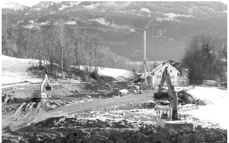
Aushub Rückhaltebecken und Baubeginn Stützmauer
