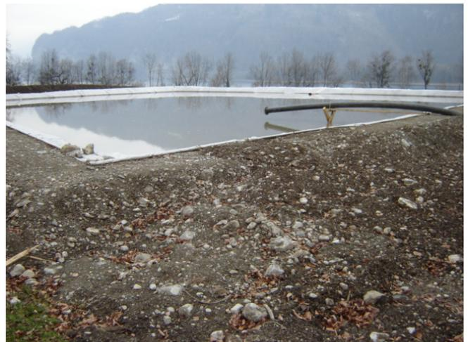
Absetzbecken mit Einlauf im Fliguet
