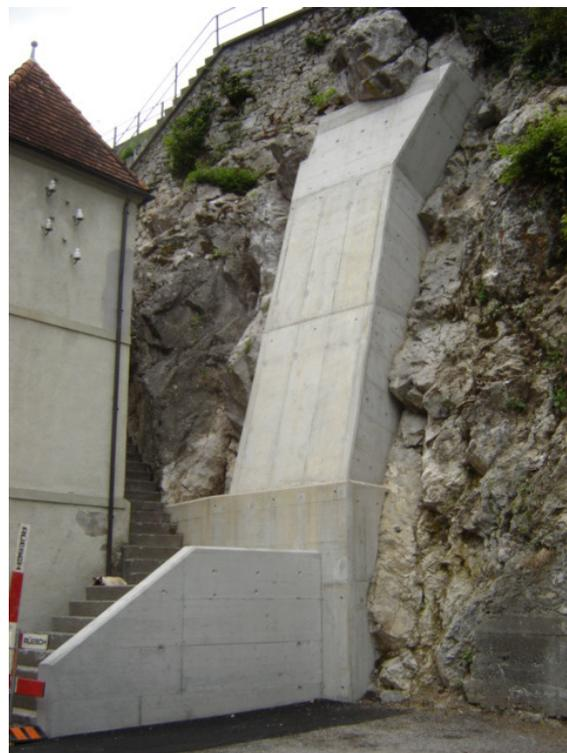
Nach dem Felsabbruch vom März 2006 hat das Kreisforstamt für die notwendigen Sicherungsmassnahmen ein Projekt ausgearbeitet, das von den Fachstellen des Kantons und des Bundes genehmigt wurde. Das Projekt umfasst die Abstützung der losen Felspartien mit einem Betonpfeiler und die Sicherung von weiteren instabilen Partien mit verankerten Felsnetzen. Die Kosten werden von Bund, Kanton und Gemeinde (ca. 20 %) getragen.
